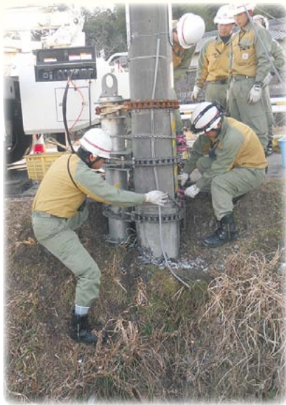
復旧作業の様子
